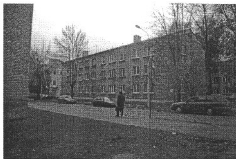
DZELZCEĻU IELAS FASĀDE
