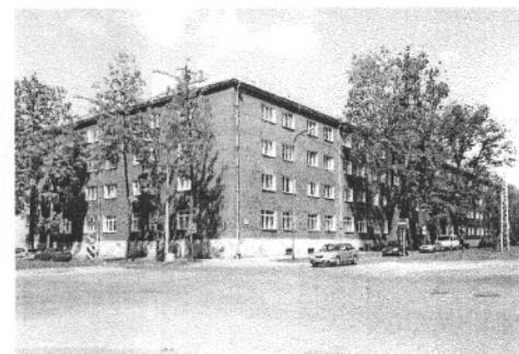
VIEŅĪBAS UN PARĀDES IELU KRUSTOJUMA FASĀDE
