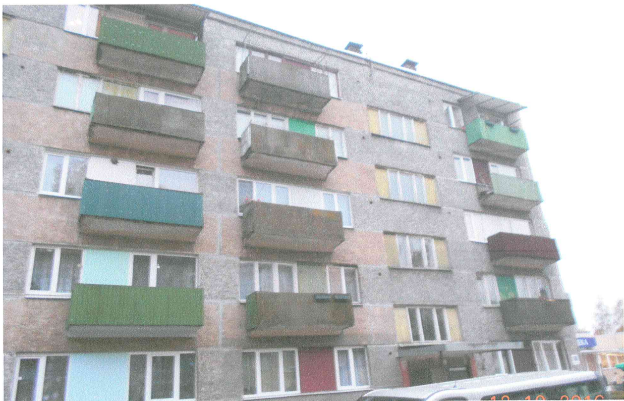
Dzīvojamās mājas Bauskas ielā 108, Daugavpilī, esošie kāpņu telpas logi
