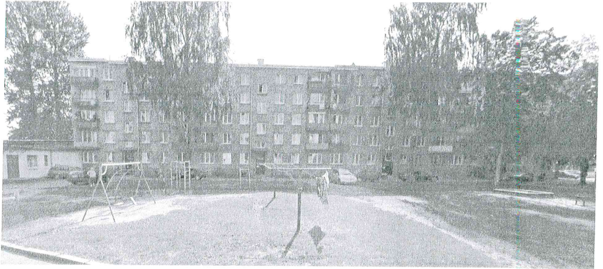
Ēkas Dobeles ielā 22, fasāde no pagalma puses.
