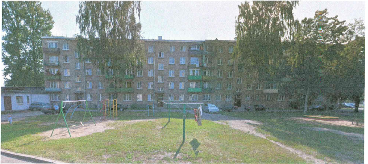
Ēkas Dobeles ielā 22, fasāde no pagalma puses.
