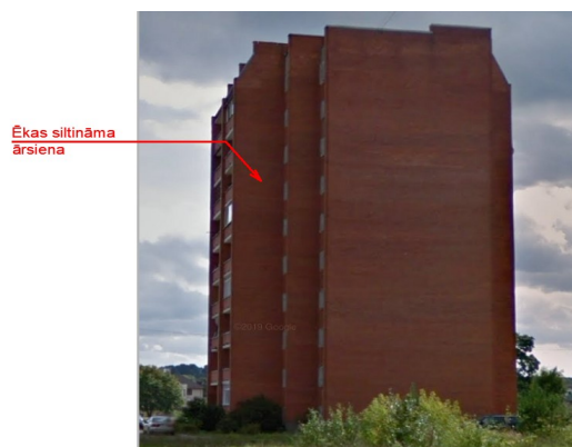
Att.Nr.5. Ēkas gala fasāde
