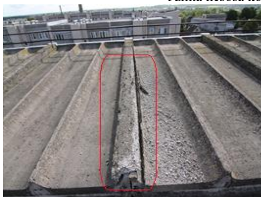
U-veida dzelzsbetona nosegu bojājums
