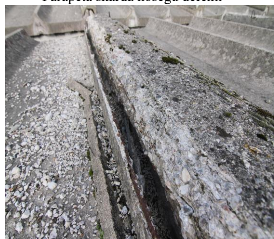
U-veida dzelzsbetona nosegu bojājums
