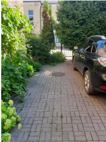
Foto Nr.7. Redzama bruģa nosēšanās pamatu nosēšanās dēļ.
