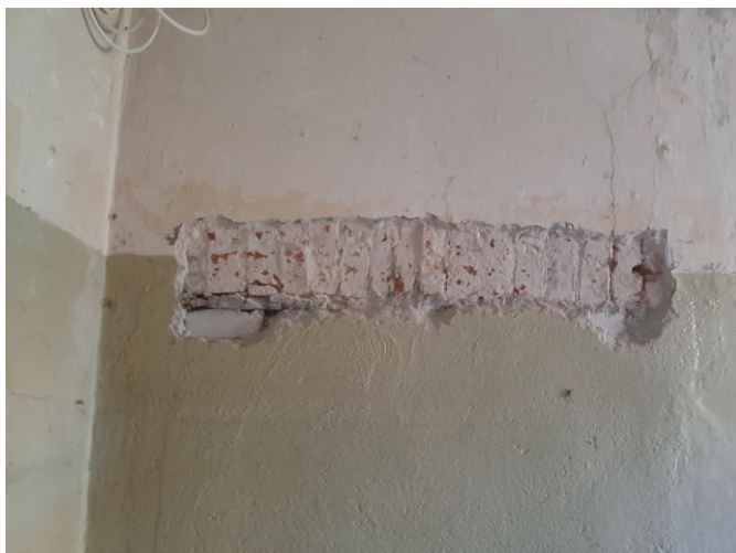
Foto Nr.14. Ailu pārsedzes ir izveidotas no māla ķieģeļa mūrējuma.
