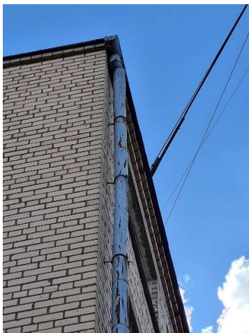
Att.Nr.1. Skats uz jumtu
