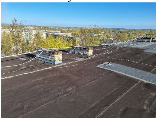
Att.Nr.7. Skats uz jumtu
