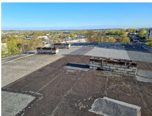
Att.Nr.5. Skats uz jumtu
