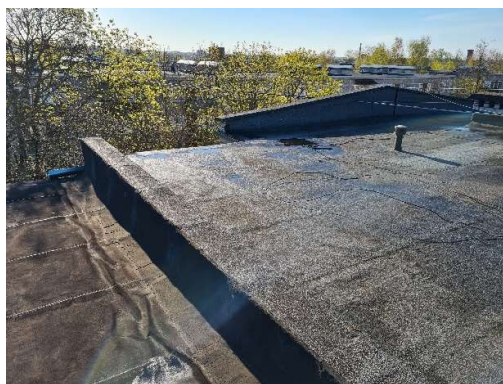
Att.Nr.6. Skats uz jumtu
