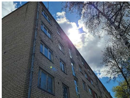
Att.Nr.2. Skats uz jumtu
