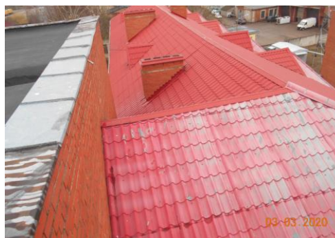
Att.Nr 8. Ēkas Balvu ielā 7, jumta pie ēkas Balvu 3 ārsienas
