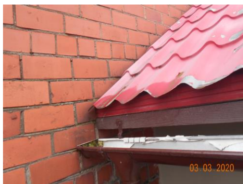
Att.Nr 7. Ēkas Balvu ielā 7, karnīze pie ēkas Balvu 3 ārsienas
