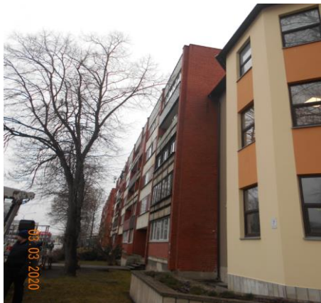
Att.Nr3. ēkas Balvu ielā 3 gala ārsiena fasāde „B” ar piebūvēto Balvu ielā 7 ēku
