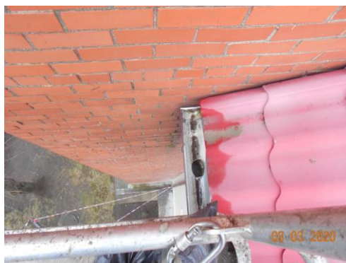
Att.Nr8. Ēkas Balvu ielā 7, karnīze pie ēkas Balvu 3 ārsienas
