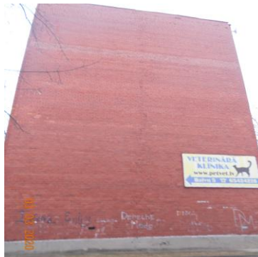
Att.Nr2. ēkas Balvu ielā 3 gala ārsiena fasāde „A”
