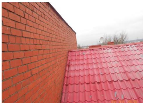
Att.Nr 8. Ēkas Balvu ielā 7, jumta pie ēkas Balvu 3 ārsienas
