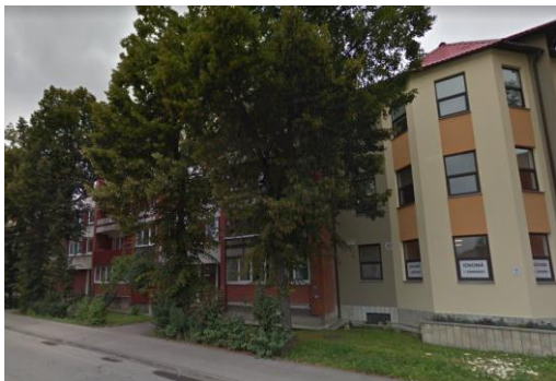
Att.Nr1. ēka Balvu ielā 3 ar piebūvēto ēku Balvu ielā 7
