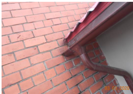
Att.Nr 6. Ēkas Balvu ielā 7, karnīze pie ēkas Balvu 3 ārsienas
