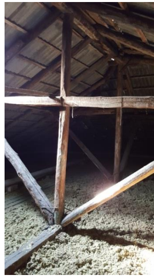
Att.Nr.6. Jumta nesošas konstrukcijas
