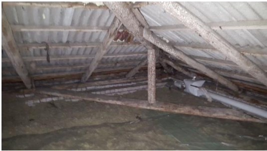
Att.Nr.3. Jumta nesošas konstrukcijas
