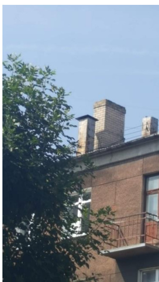
Att.Nr.1. Skats uz jumtu
