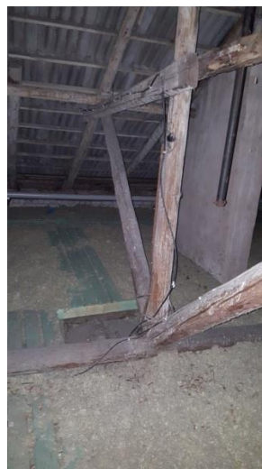
Att.Nr.8. Jumta nesošas konstrukcijas
