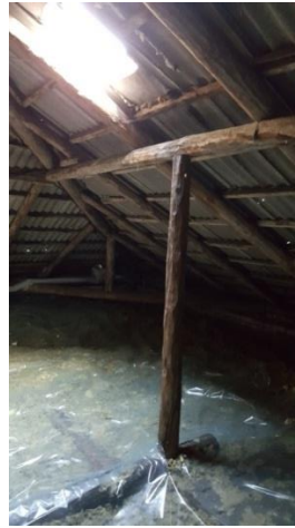
Att.Nr.4. Jumta nesošas konstrukcijas
