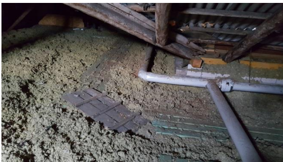
Att.Nr.7. Jumta nesošas konstrukcijas
