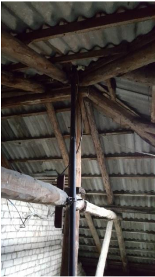
Att.Nr.5. Jumta nesošas konstrukcijas
