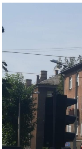
Att.Nr.2. Skats uz jumtu
